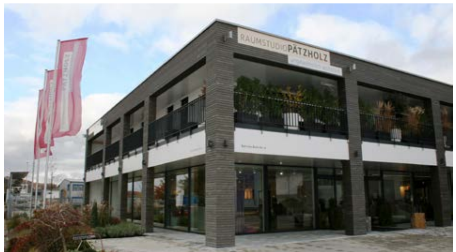
Das Raumstudio Pätzholz hat einen eindrucksvollen Neubau mit umlaufendem Laubengang im Gewerbegebiet Nord von Rielasingen errichtet. Die Verkaufsfläche umfasst 1.000 m 2 .
